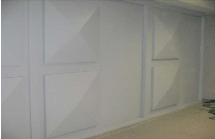
Sala de Grabación TERRA
