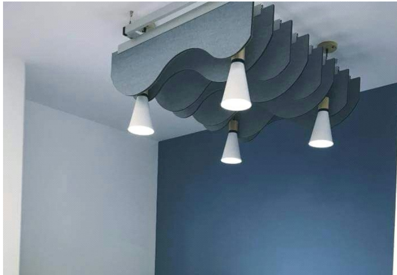
Acondicionamiento acústico con Cronatur Float de la sede central de HP (Hewlett Packard en San José de Costa Rica).
