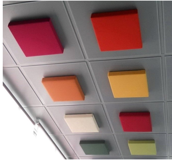
Panel Croxon Layna (50 x 450 x 450 mm) instalado sobre paneles modular convencional
